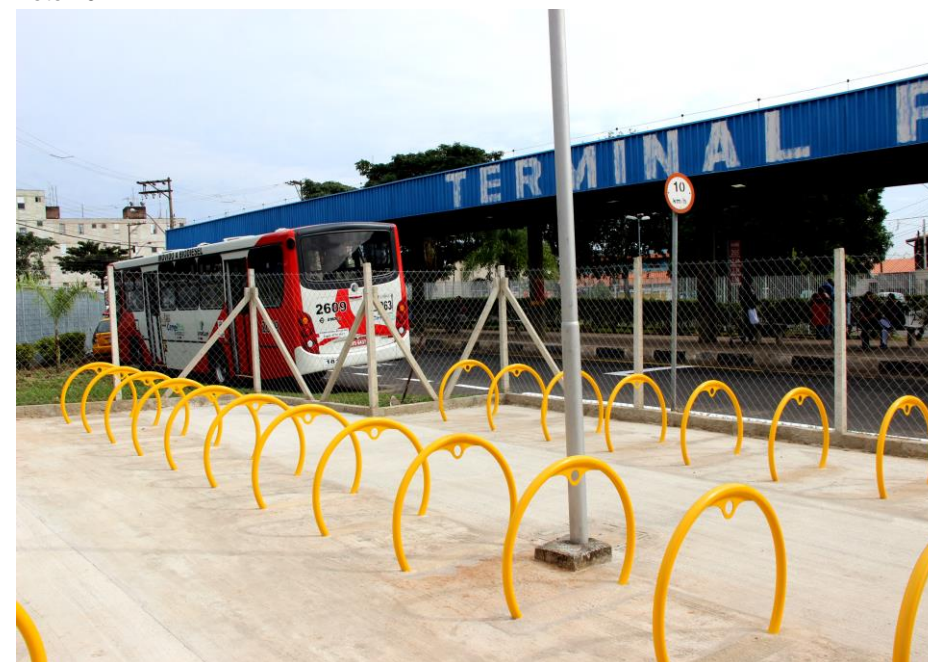
Terminal Padre Anchieta – Campinas – SP – Fonte: EMDEC
